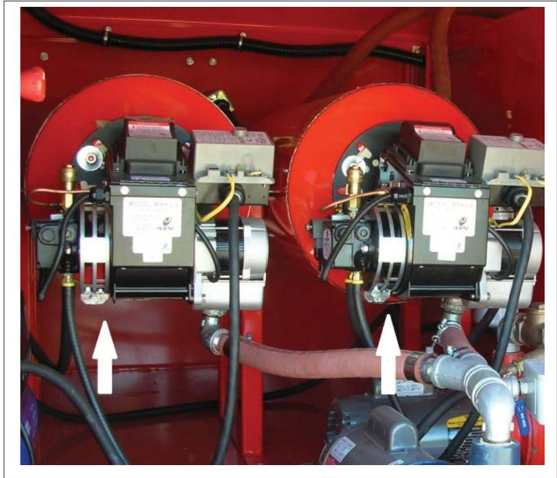
Fig. 54 BURNER AIR BANDS
